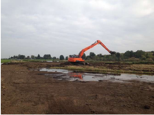
Aanleg gruttolandje oktober 2016
